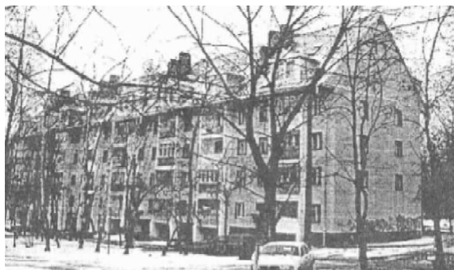
Рис. 5. г. Лыткарино. Кирпичный дом после реконструкции
